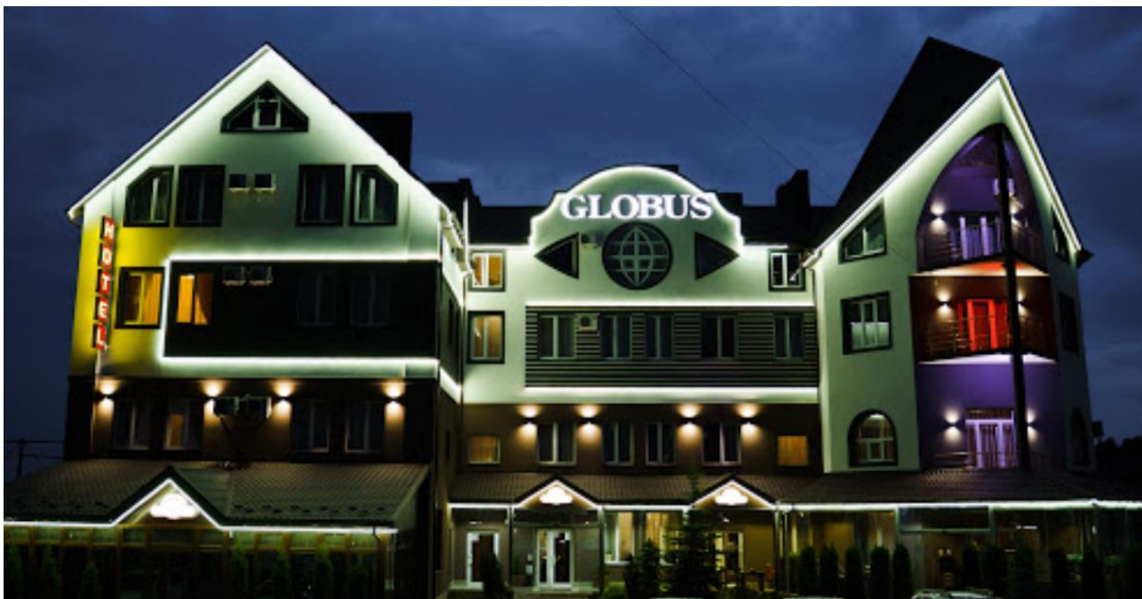
Рисунок 2.1. Загальний вигляд готельного комплексу «Глобус»
