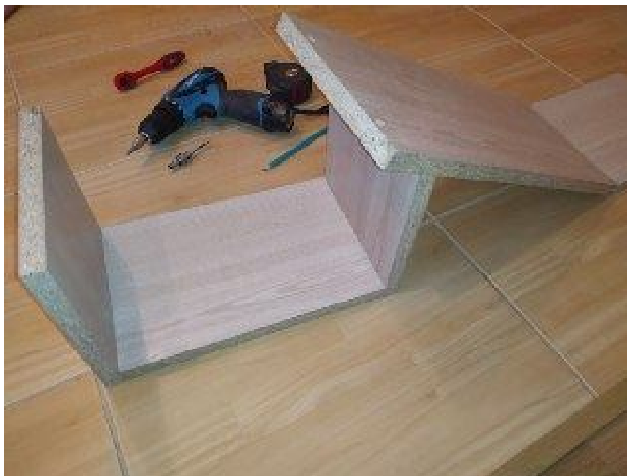
Рисунок Д.4 – Скручування полиць
